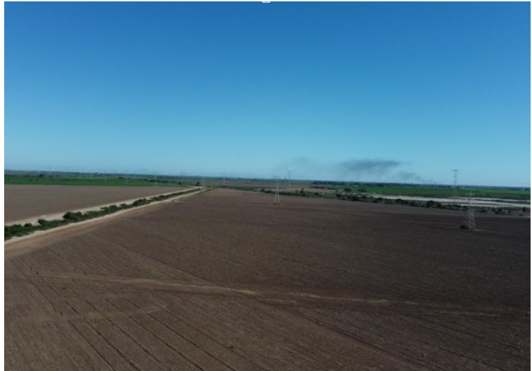
Figura 3: Vista aérea del sitio del Proyecto
