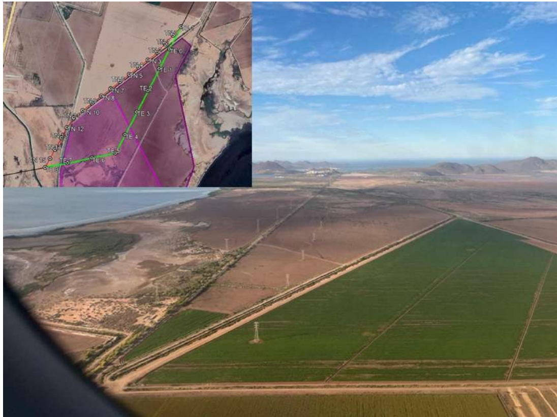
Figura 3.13: Líneas eléctricas aéreas que se reubicarán durante las primeras obras
